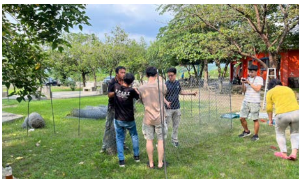
▲ 雞舍圍鐵網作業
